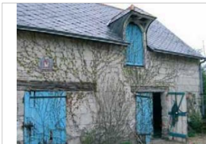
Vue du site
