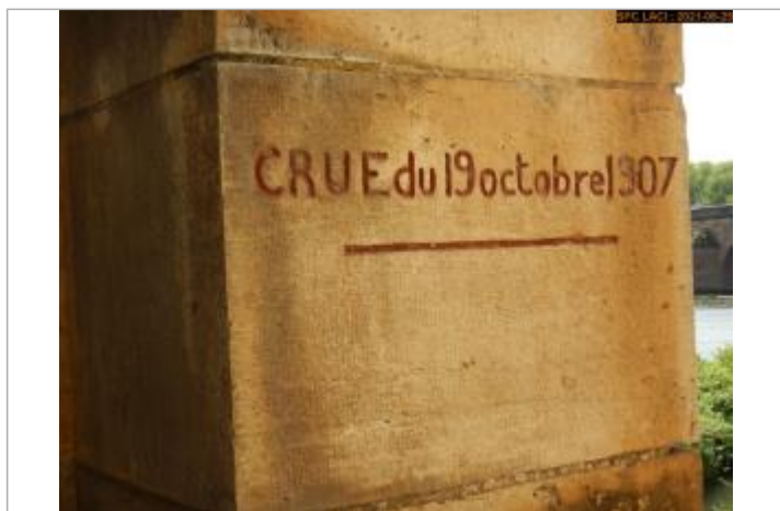
Vue du repère rapprochée
