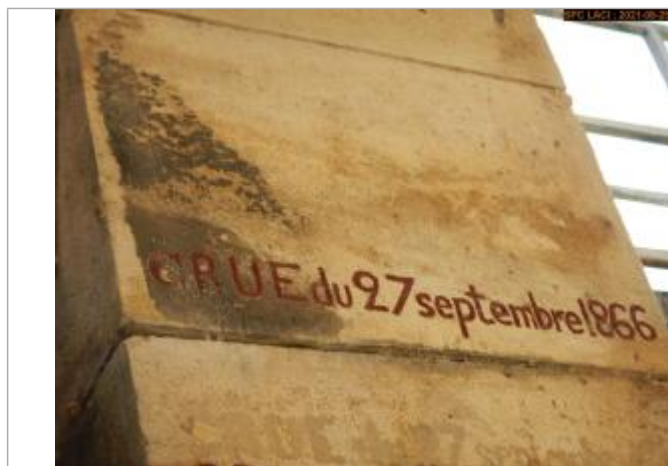
Vue du repère rapprochée
