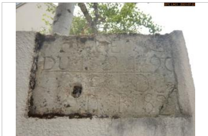
Vue du repère en 2021
