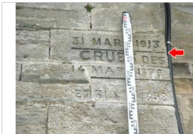
Vue du repère (recensement d'origine)
