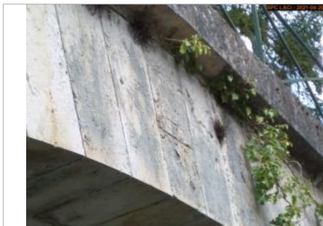
Vue du repère en 2021 milieu pont côté aval
