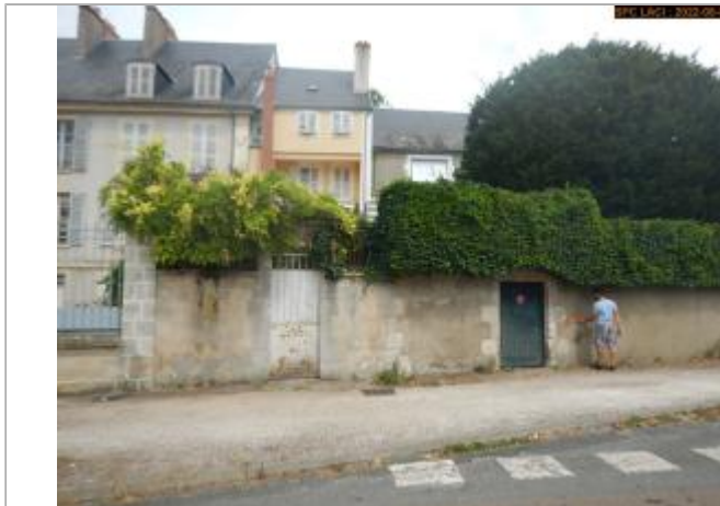
Vue du site éloignée
