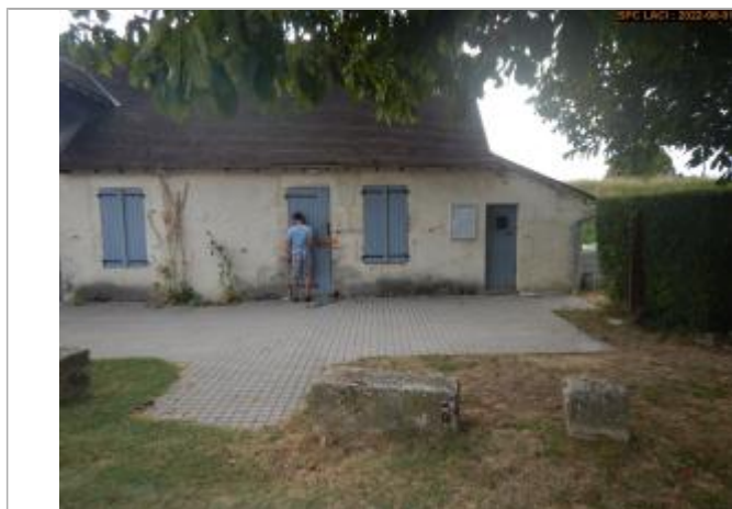
Vue du repère gravé éloignée (2ème porte)
