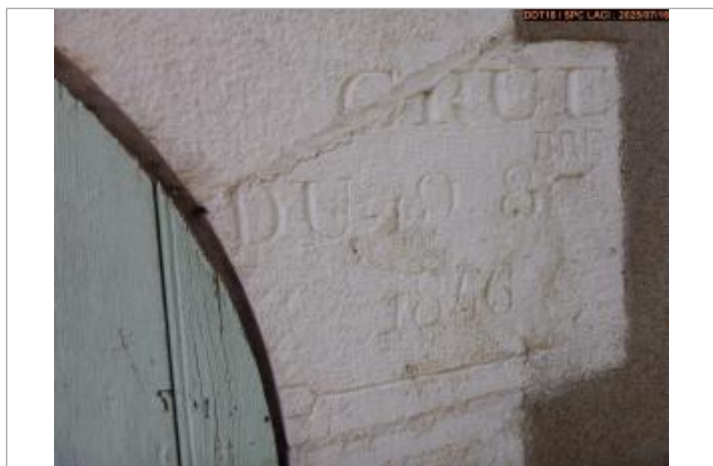
Vue du repère côté montant droit porte
