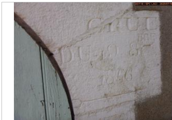
Vue du repère côté montant droit porte
