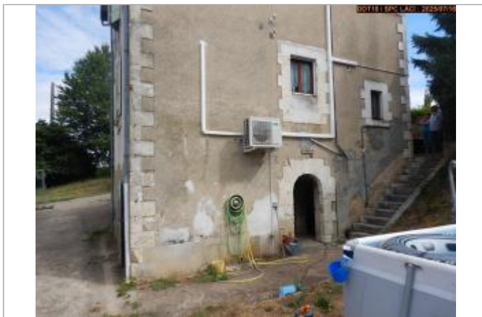
Vue du site
