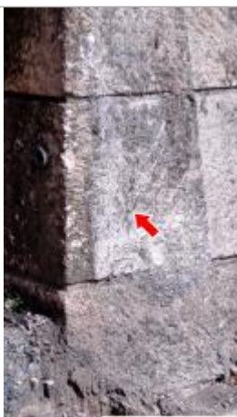
Vue du repère pendant les travaux de la digue en juillet 2023
