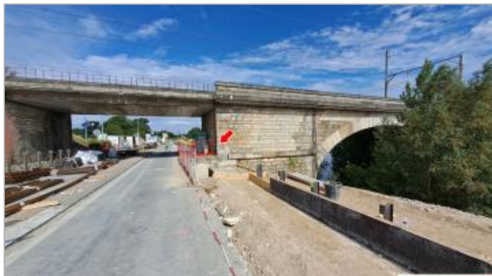
Photo du site pendant les travaux de la digue, en juillet 2023
