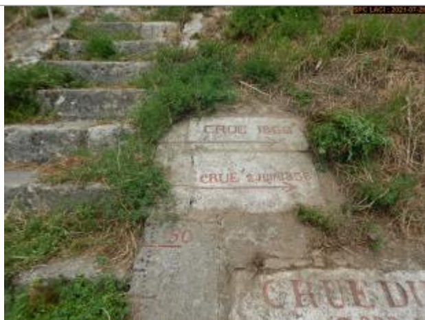
Vue du repère rapprochée en 2021 escalier côté pont
