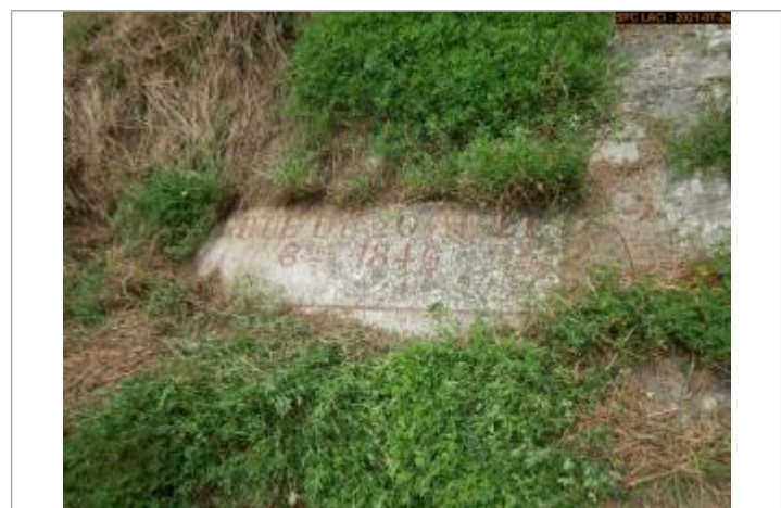
Vue du repère rapprochée en 2021 escalier côté rampe
