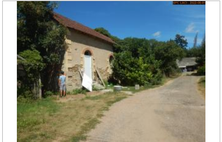
Vue du site éloignée
