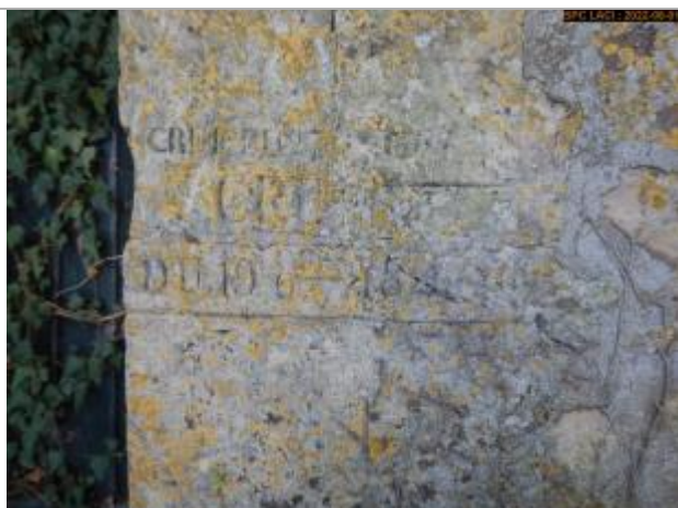
Vue du repère (Pilier droit)
