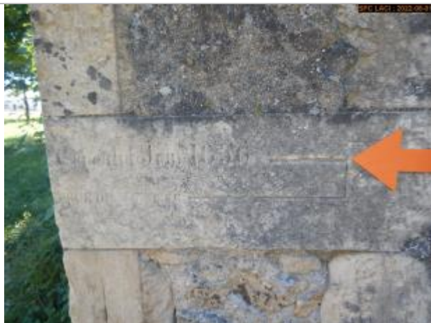
Vue du repère éloignée (côté angle)
