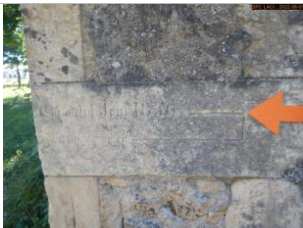
Vue du repère éloignée (côté angle)
