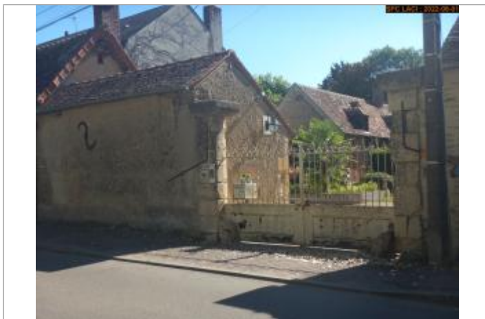
Vue du site éloignée
