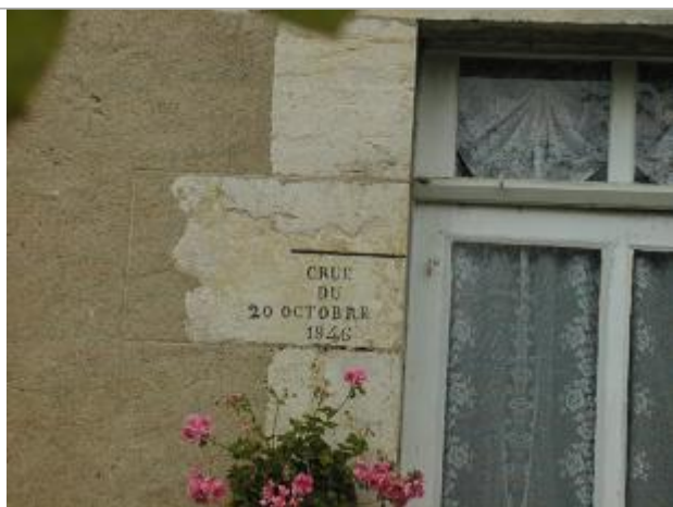
Vue du repère (recensement d'origine)
