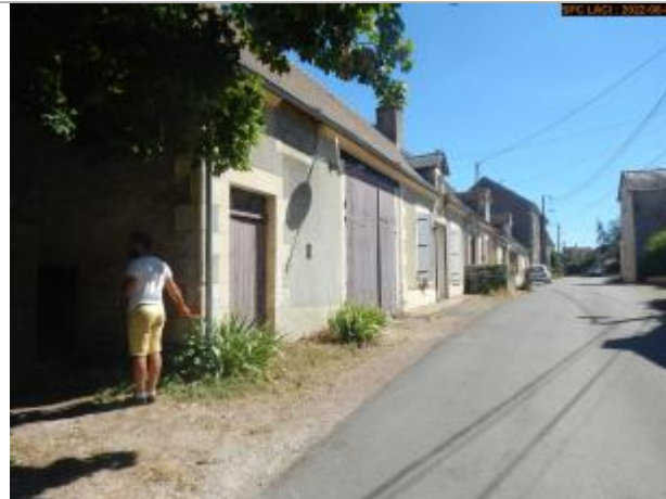
Vue du site éloignée
