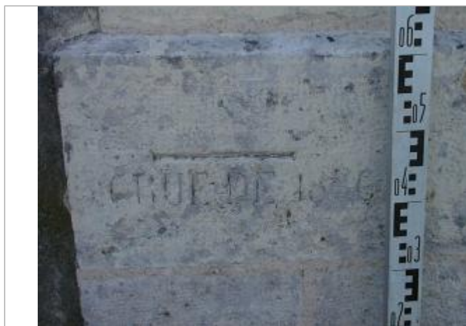
Vue détaillée du repère
