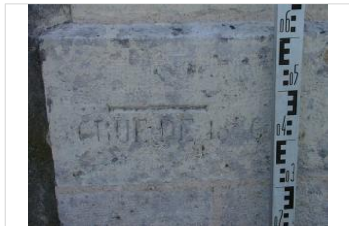
Vue détaillée du repère
