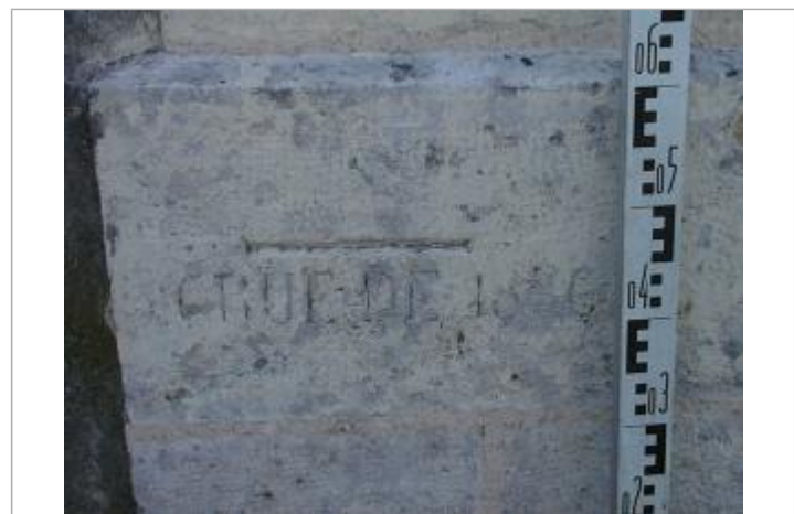
Vue détaillée du repère
