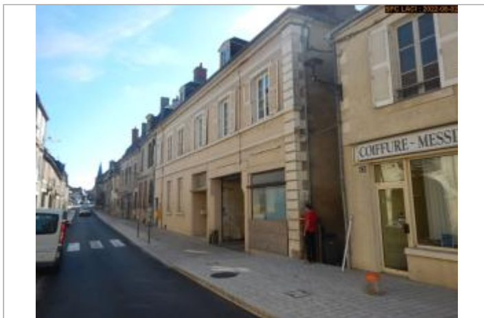
Vue du site éloignée
