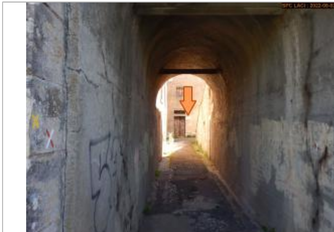
Vue du site éloignée
