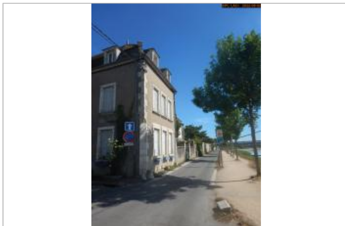
Vue du site éloignée
