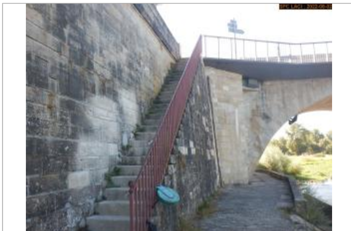
Vue du site éloignée
