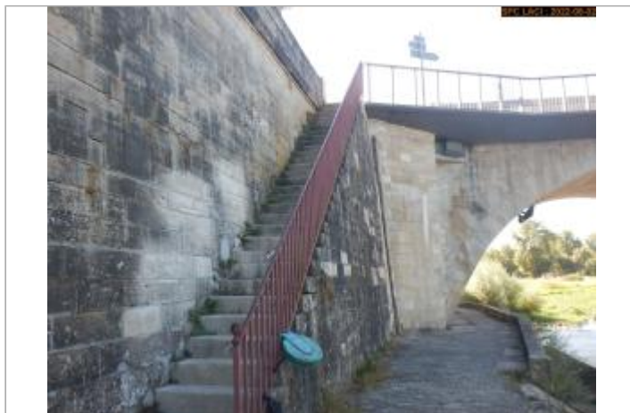
Vue du site éloignée
