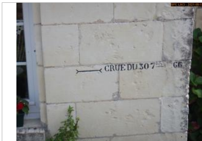
Vue du repère en 2021
