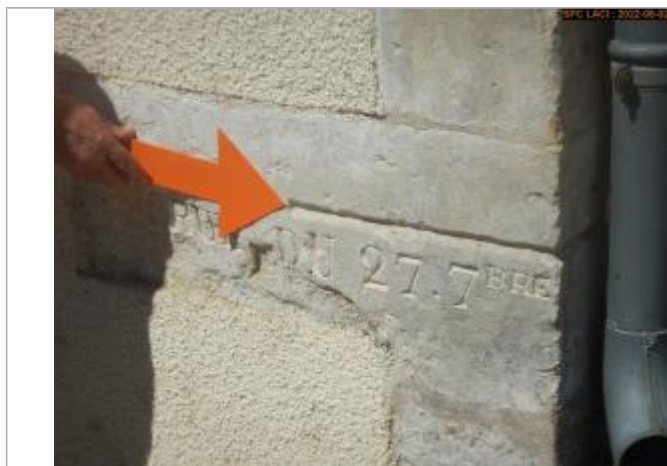
Vue du repère (angle de maison)
