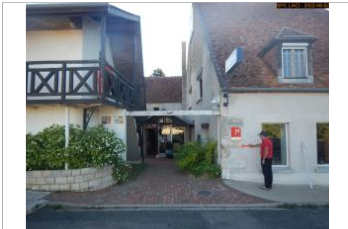
Vue du site éloignée
