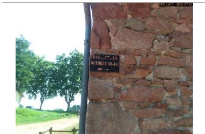
Plaque noire sur le mur du bâtiment côté canal à proximité de la gouttière
