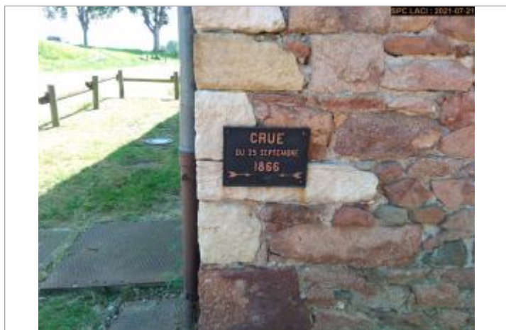
Plaque noire sur angle du bâtiment côté canal à proximité d'une gouttière grise
