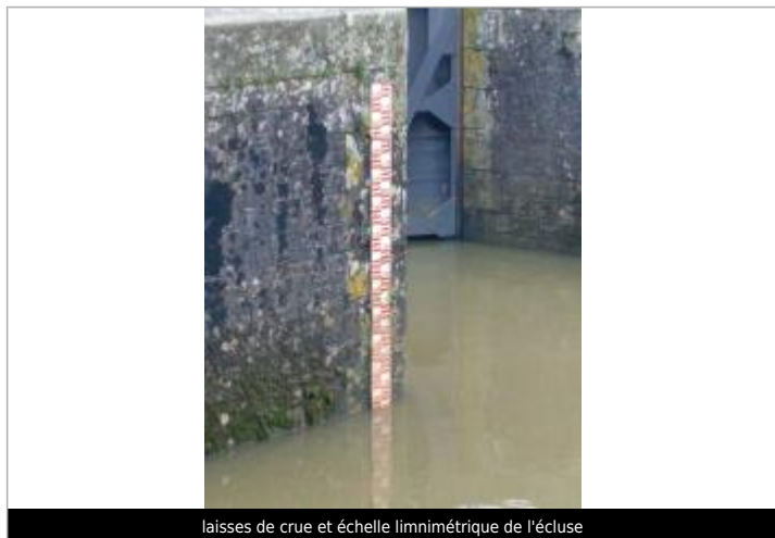
laisses de crue et échelle limnimétrique de l'écluse
