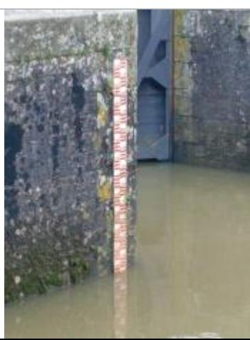
laisse de crue et échelle limnimétrique de l'écluse
