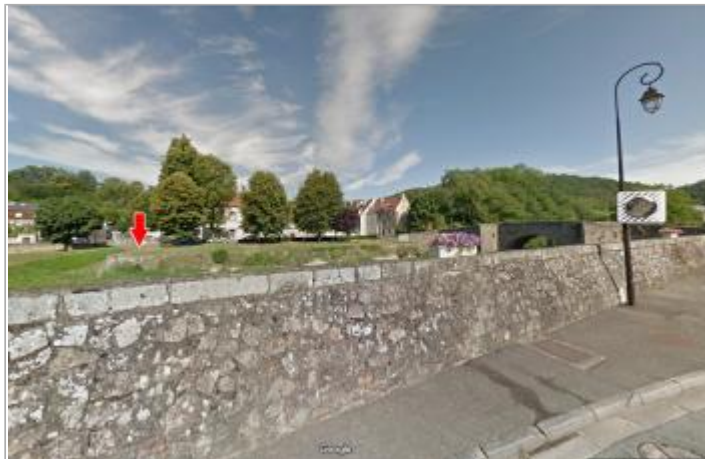
Vue du site en 2018, depuis le quai Napoléon (source : Google Street View)
