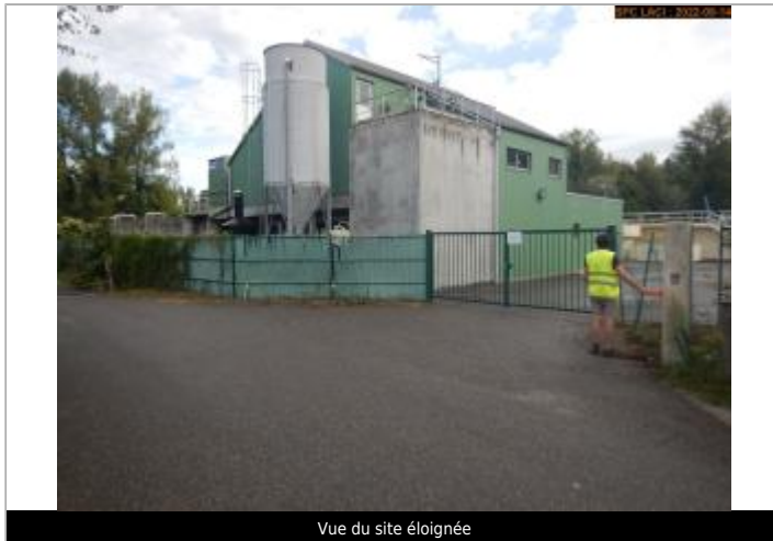
Vue du site éloignée
