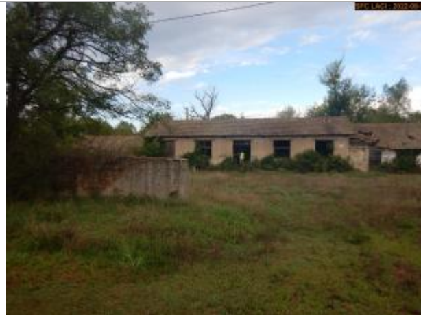
Vue du site éloignée
