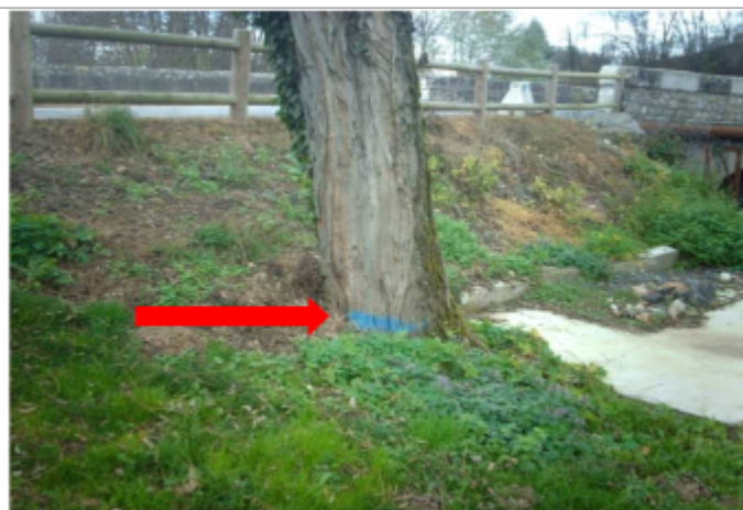
Vue du site en 2009 (source : Sarl GEOA)
