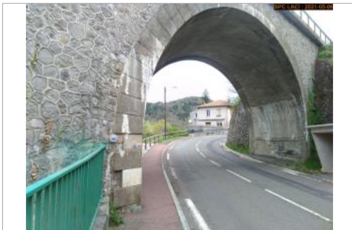
Vue du site côté amont Loire en 2021
