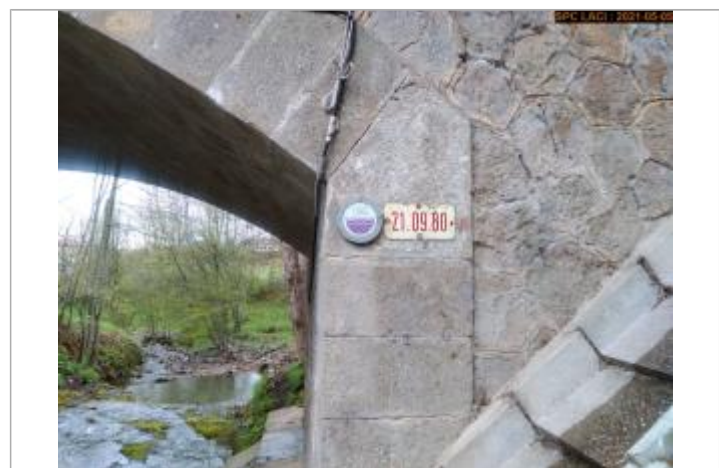
Vue des repères en 2021 côté amont
