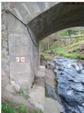
Vue du repère en 2021 côté aval
