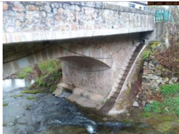
Vue du site en 2021 côté amont
