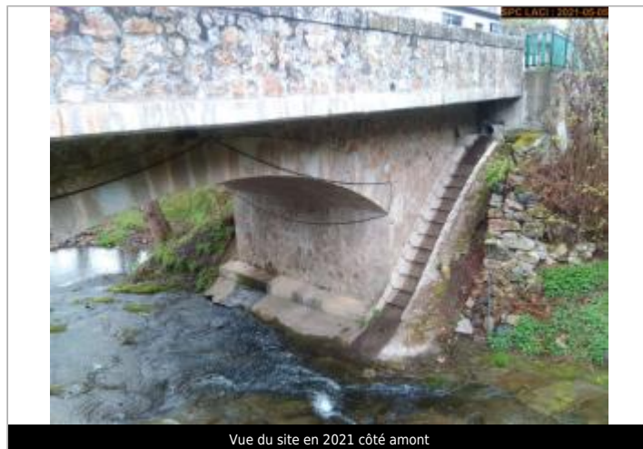
Vue du site en 2021 côté amont
