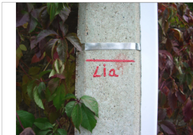
Vue du repère le 06/10/2008 (source : cabinet Leurent)
