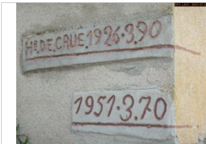
Vue du repère rapprochée
