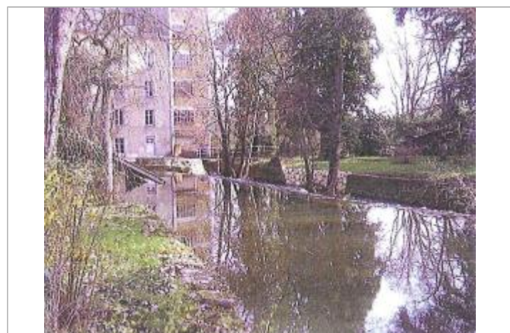
Vue de la crue
