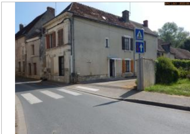
Vue du site (entrée du chemin privé) en 2022
