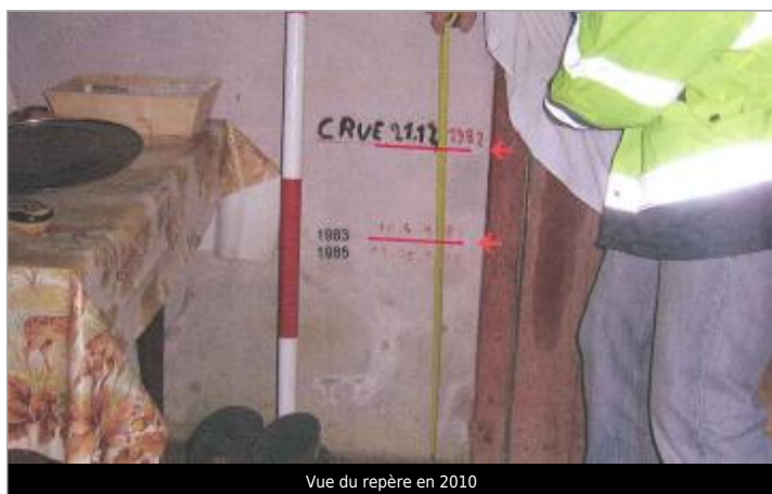
Vue du repère en 2010
