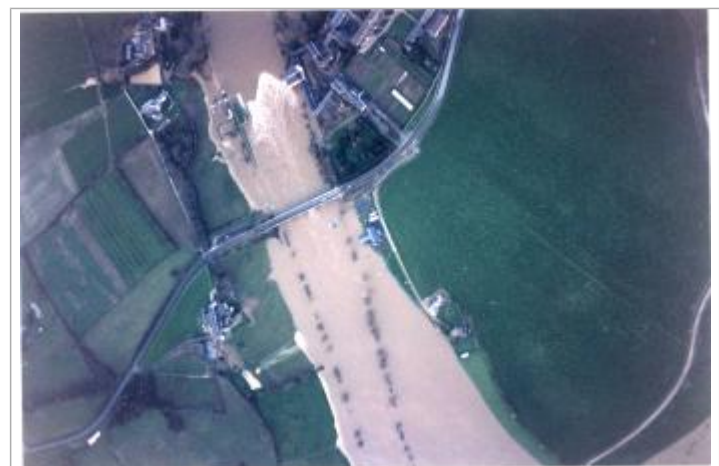
Vue de la crue
