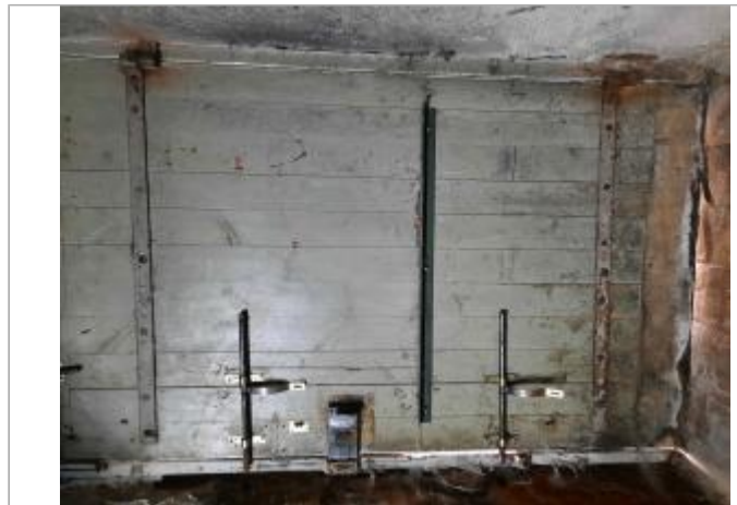
Vue de l'intérieur du cellier
