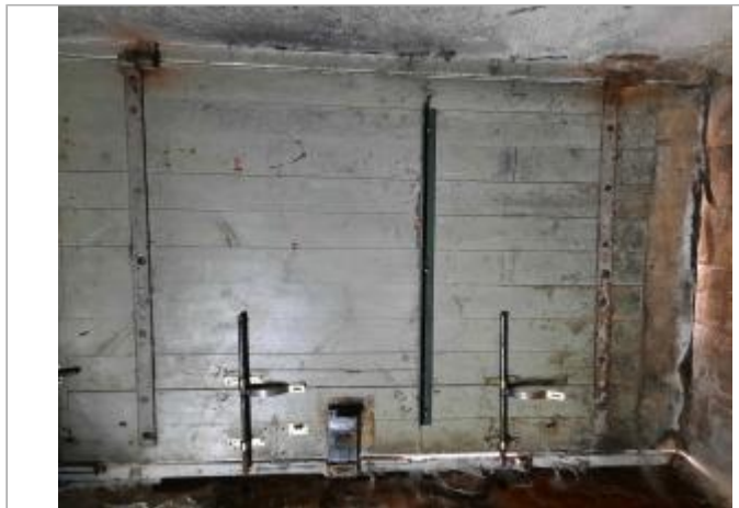
Vue de l'intérieur du cellier
