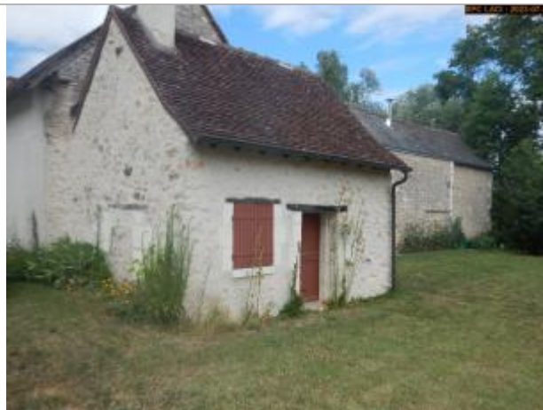
Vue du site (repère N°1) en 2023
