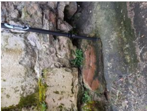
Vue de la laisse - Auteur : SPC MLA
