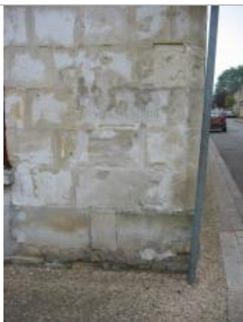
Détail du repère, en 2002 (source : DDE 37)
