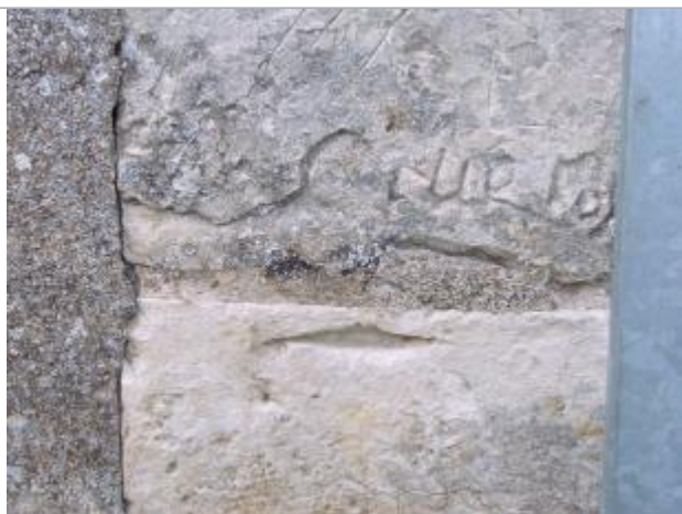
Vue du repère (recensement d'origine)
