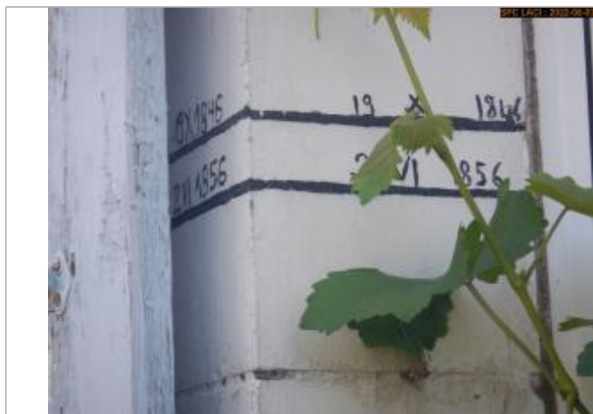
Vue du repère (montant intérieur)
