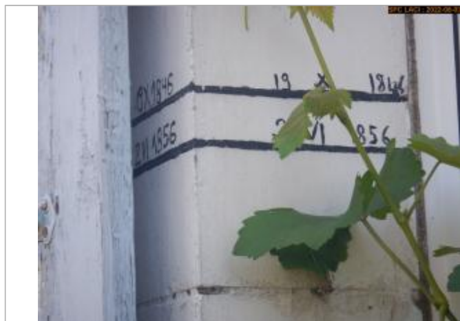
Vue du repère (montant intérieur)
