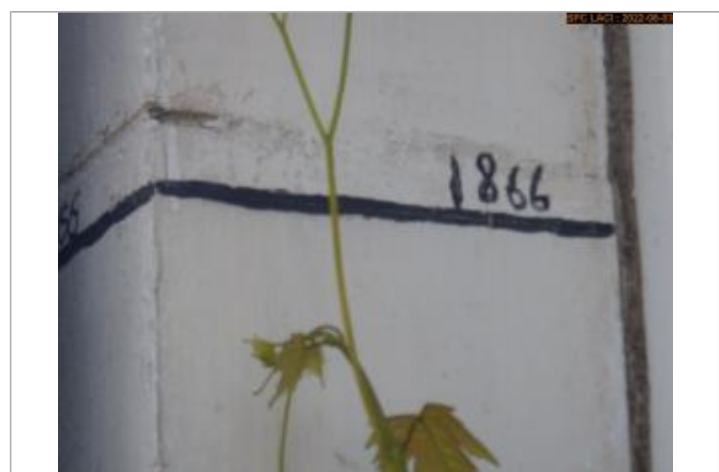
Vue du repère (montant intérieur)
