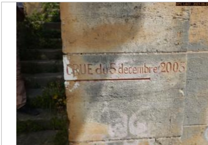
Vue du repère rapprochée
