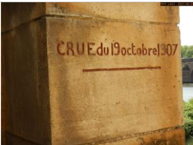
Vue du repère rapprochée
