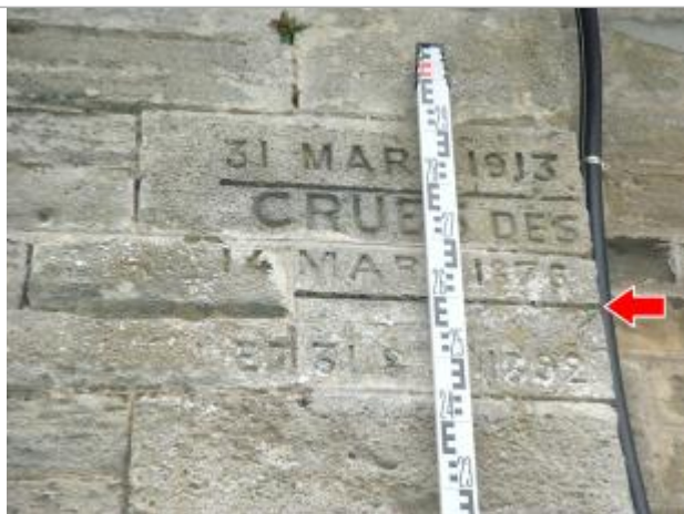
Vue du repère (recensement d'origine)
