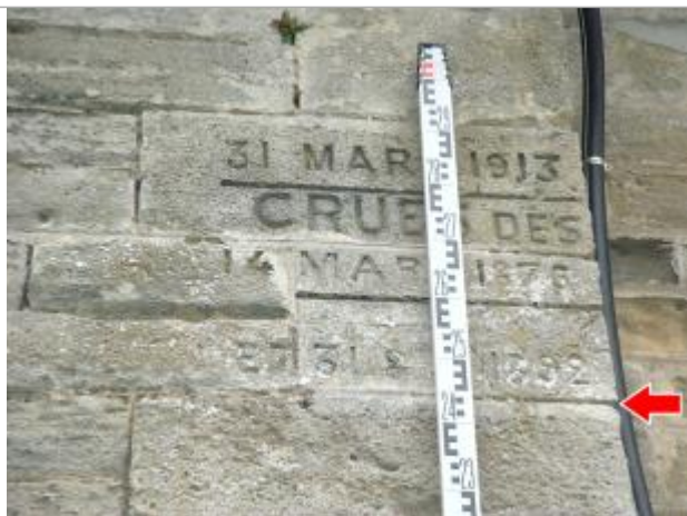
Vue du repère (recensement d'origine)
